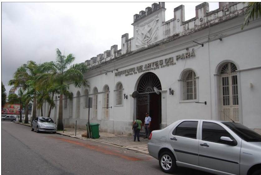
Imagem 1: Coletivo Rede[Aparelho]-:, Sangria Desatada - Mapeamento da tortura em Belém, 2009. Fotografia digital. Local: 5ª Companhia de Guardas do Exército. Atual Instituto de Artes do Pará - IAP. Fonte: http://redeaparelho.blogspot.com.br/2009/04/sangria-desatada-mapeamento-da-tortura_05.html
